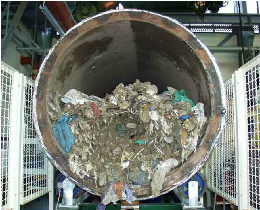
Abbildung 3 Geöffneter Reaktor nach Versuchsende (Inputmaterial: unzerkleinerter Restabfall)
